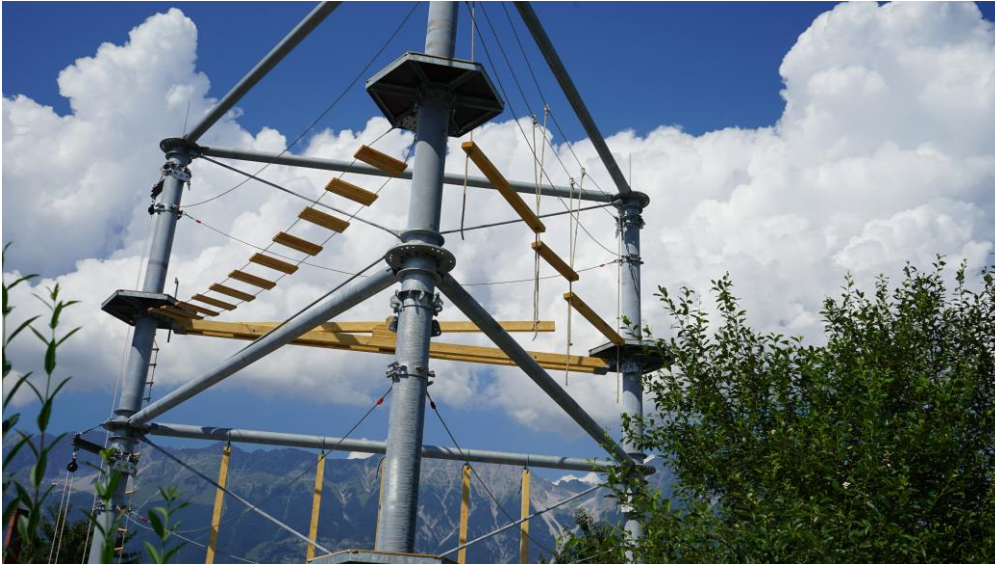
Auf zwei Ebenen wird der Kletterturm erklommen.
